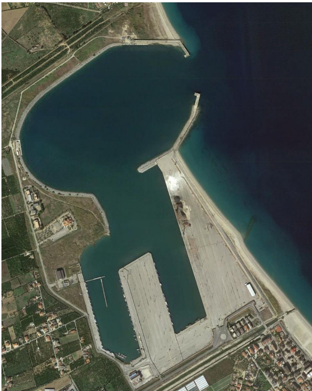
Figura 1. Porto di Corigliano Calabro – Vista dal satellite (2019)
